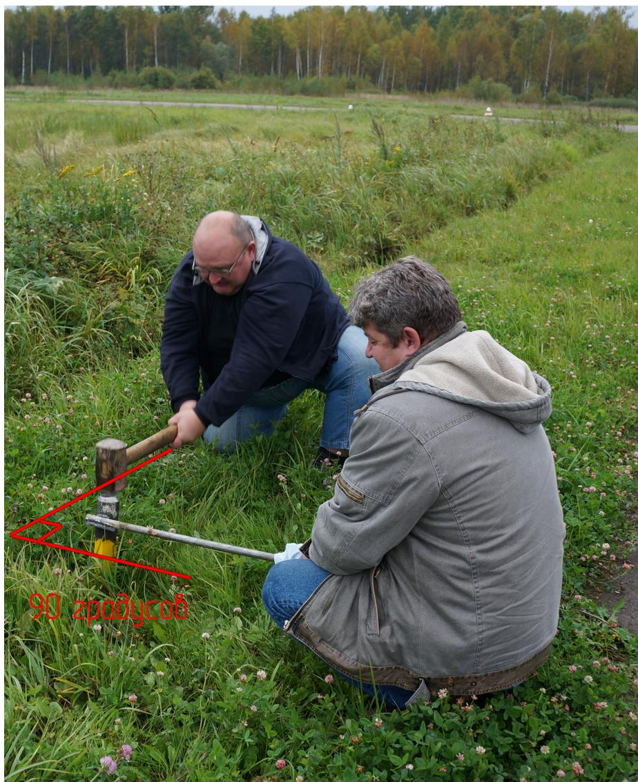
Игла забивается на 1-2 см ниже уровня грунта уголком, таким образом, чтобы над поверхностью была только трубка крепления стойки. После забивания иглы на неё монтируется стойка и огонь с кронштейном на стойку диаметром 40мм.
